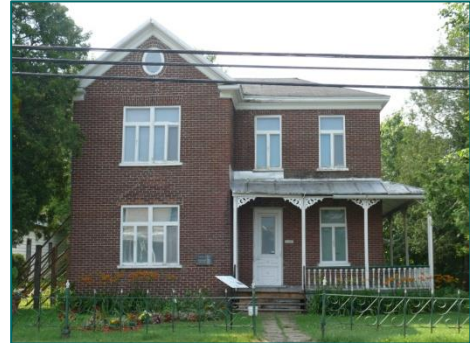
La maison Plamondon Crédit photo : Patri-Arch
